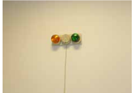
Indicador lumínico y sonoro de emisión de radiación, para la prohibición de ingreso.
